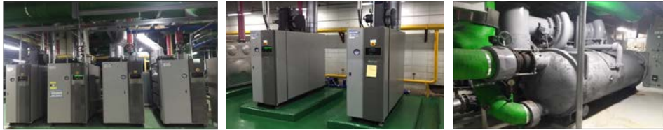
<대구점 보일러 설치>
