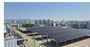
[롯데쇼핑] 태양광 패널 설치
